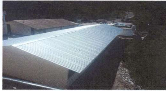
Foto 2: Sustitución de Capote de lámina, para lámina troquelada (Módulo 1 de Aulas)
