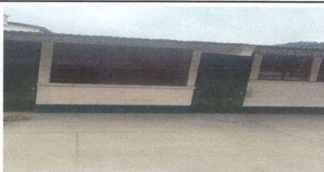
Foto 6: Sustitución de puertas de metal (Módulo 2 Aulas )
