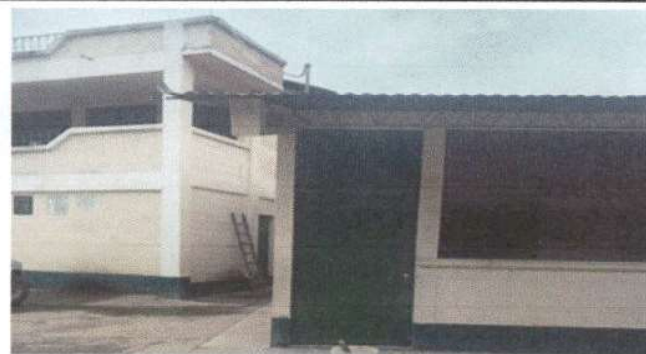
Foto 4: Sustitución de Puertas de metal 1X2.93 mts. (Módulos 1 Aulas)
