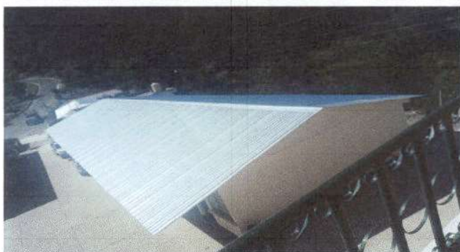
Foto1: Sustitución de lámina por lámina troquelada Azulic Calibre 26 (Módulo 2 de Aulas)
