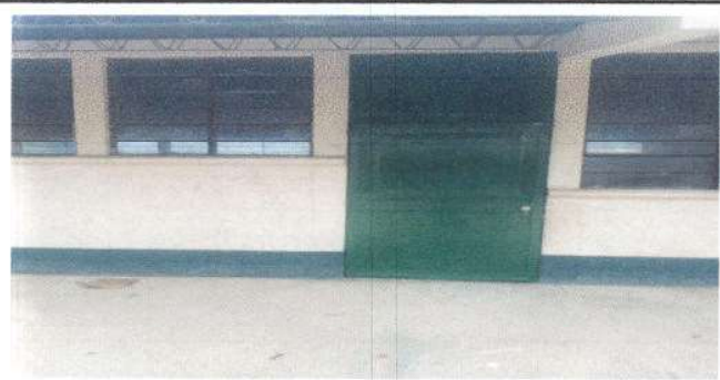
Foto 5: Sustitución de puerta de metal (Módulo 1 Aulas)
