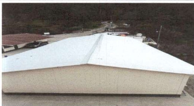
Foto 3: Sustitución Elementos de Fijación
